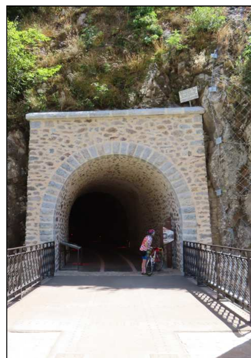
Entrée du tunnel.
